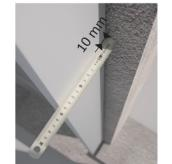
Planéité générale Les défauts de planéité sont mis en évidence à la règle de 2 m : maximum admissible de 10 mm.
